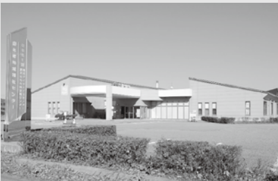
復旧したとぎ地域福祉センター
