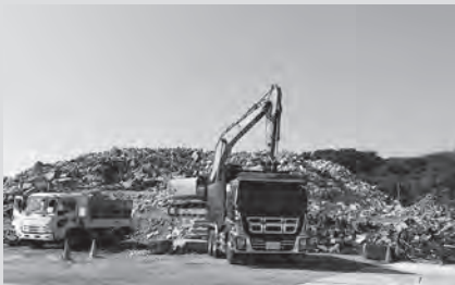
災害ごみ仮置場
