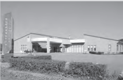
復旧したとき地域福祉センター
