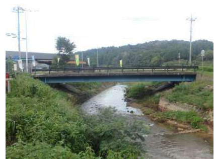
上棚出橋 橋長 22.0m 1969 年架設
