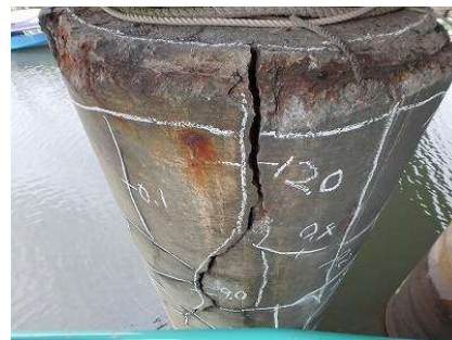
橋脚のコンクリート
