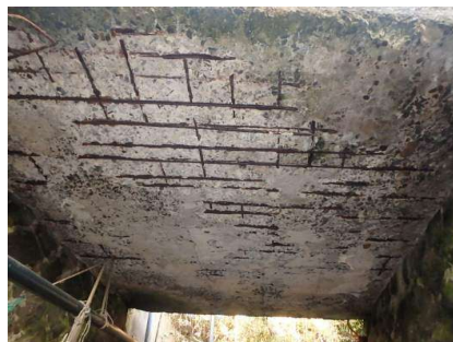
コンクリート橋の床版
