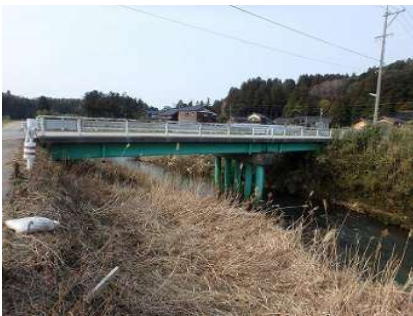
地の丸橋 橋長 26.1m 1973 年架設
