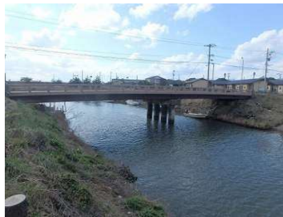
浜の橋 橋長 39.0m 1971 年架設
