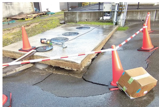
損傷した稗造防災センターの浄化槽
