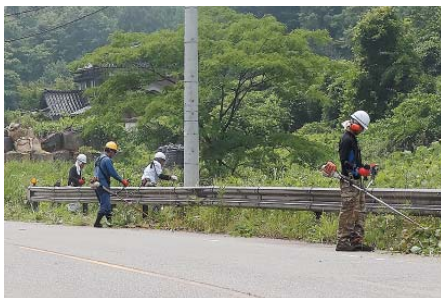
安全対策のため行われる除草作業
