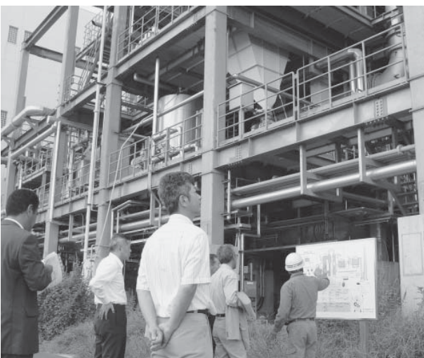
下水汚泥を利用して発電する取組を視察する議員。
