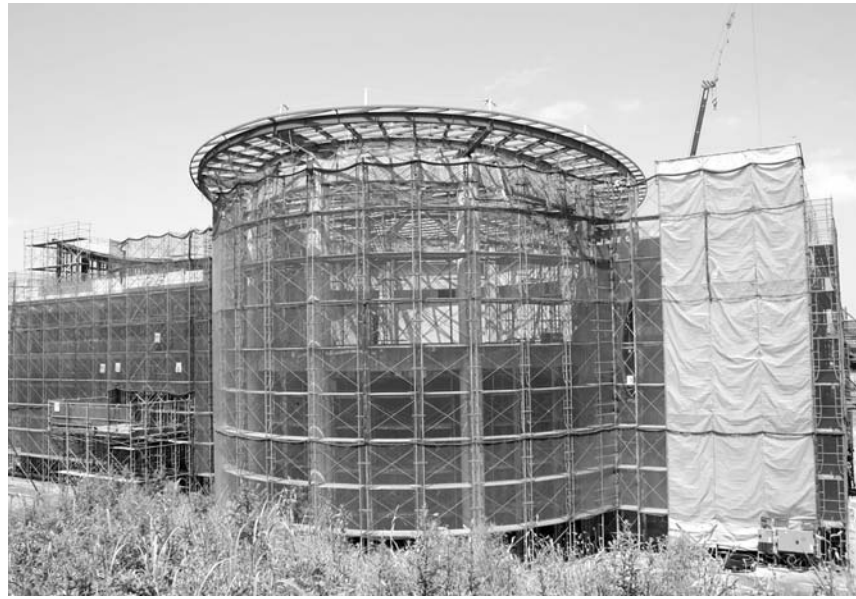
建設中の統合中学校(7月20日現在)
