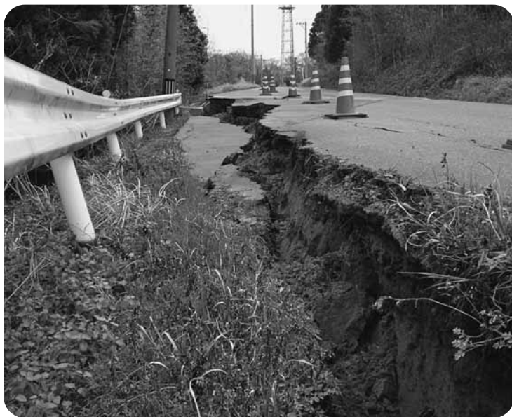
震災復旧は緊急度の高いものから着手する。写真は、町道東小室里本江線、給分地内。
