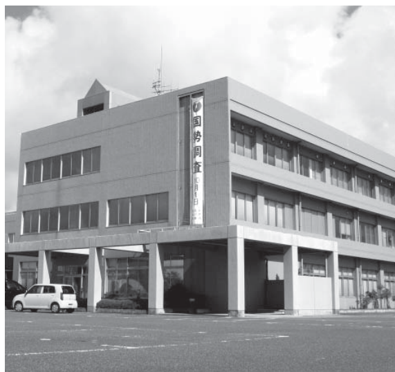
公共施設避難所と一時避難ビルの計70箇所で標高測量と標識を設置します。(写真は富来支所)
