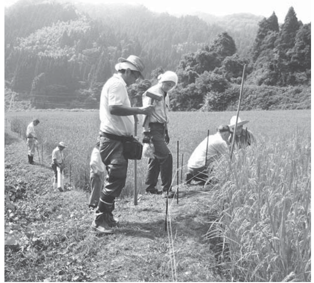
電気柵の設置作業
