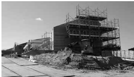
志賀小学校横に建設中の放課後児童クラブ
