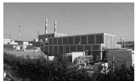
志賀原子力発電所
