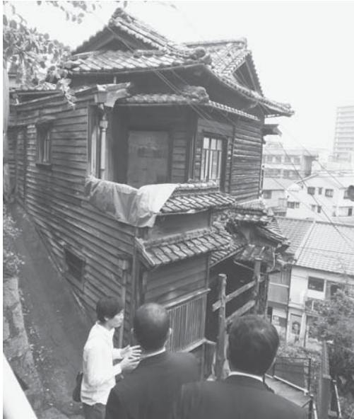
再利用のため改修中の昭和初期の空き家
