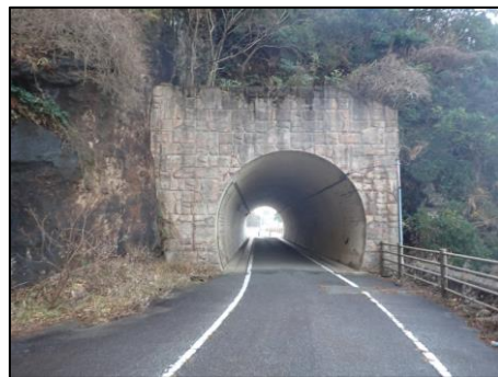
荒木第二隧道
