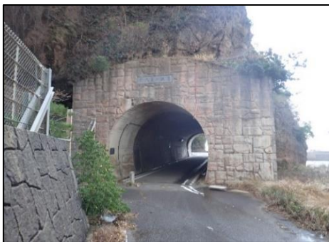
荒木第一隧道
