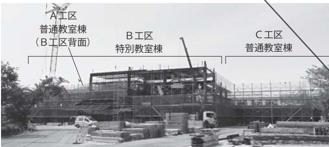
現在の工事の状況
